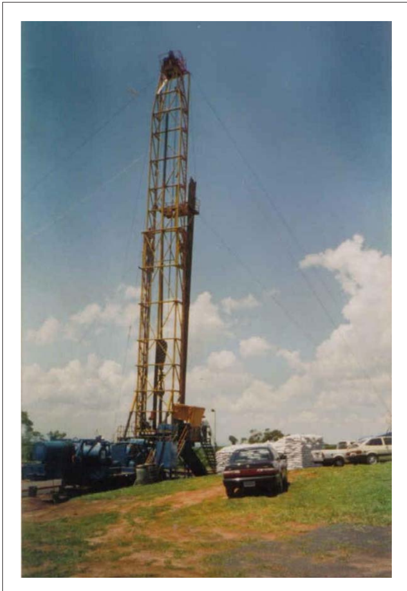
Figura 6.- Equipamento de perfuração rotativo.
