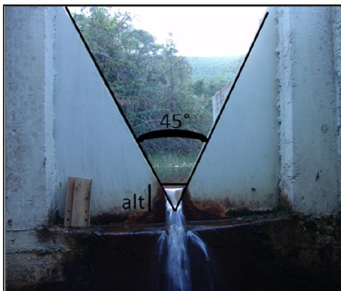
Figura 2 - Barragem com vertedouro triangular com abertura de 45° instalado na microbacia Vai e Volta (MECII).
