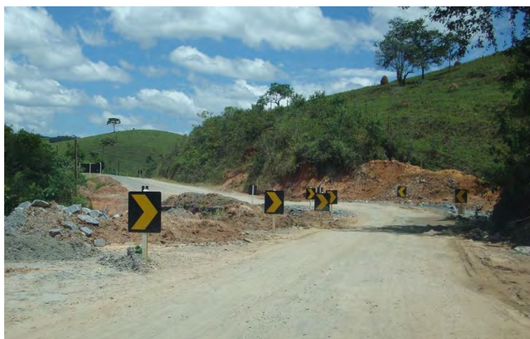
Figura 36. Desvio na MG - 132 ocasionada por erosão da pista
