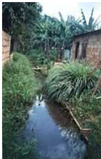
Figura 11 – CASA ERGUIDA “DENTRO” DO CÓRREGO DO ATOLEIRO (PRÓXIMO DA HORTA COMUNITÁRIA)
