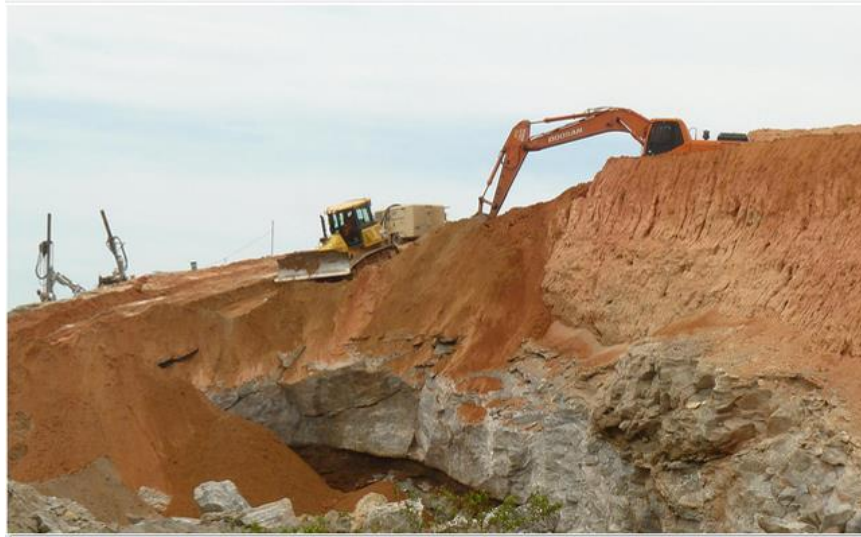
Figura 5: Decapeamento e retirada do solo para exposição da rocha no local a ser explorado. Fonte: CRAFT Engenharia, 2013.
