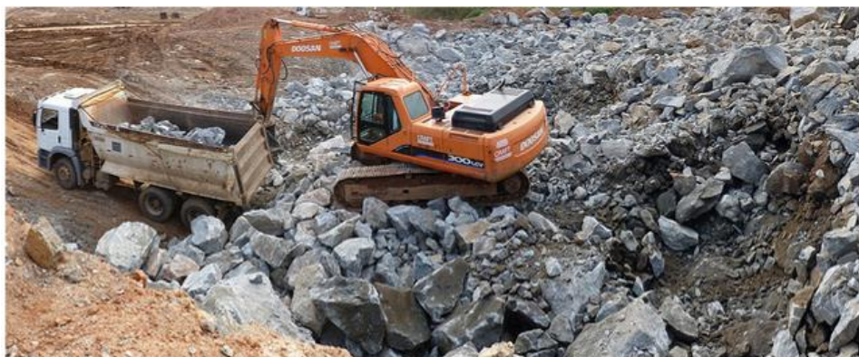
Figura 8: Preparação (pré-fragmentação) e carregamento dos caminhões com o material de desmonte primário para o transporte para o processo de britagem. Fonte: CRAFT Engenharia, 2013.
