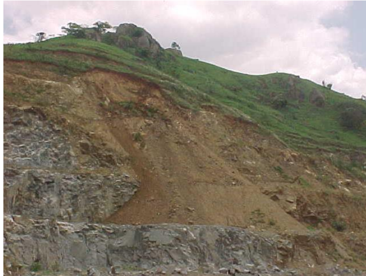
Figura 15 - Desmoronamento do talude no topo da cava final de uma pedreira da RMRJ. (Oliveira, 1996).
