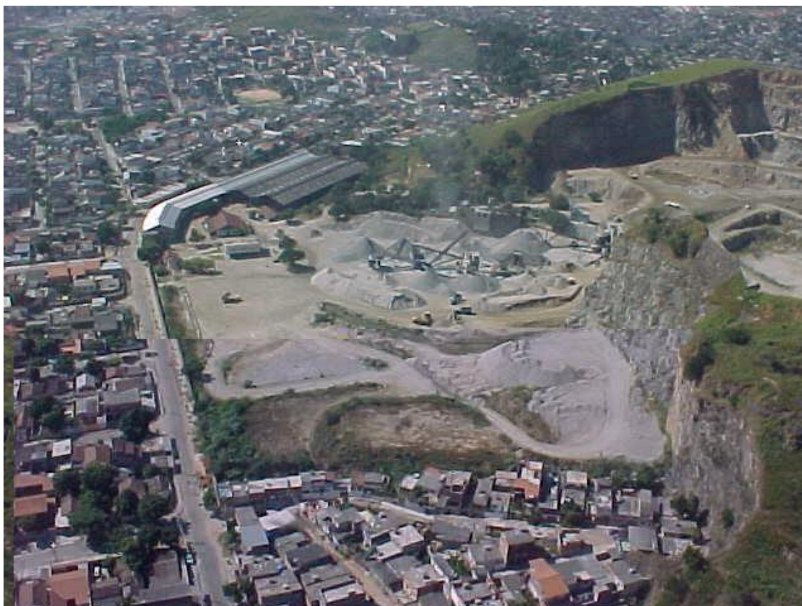
Figura 11 - Pedreira i que se instalou antes da malha urbana, porem hoje se encontra no seu interior, limitando sua vida útil (OLIVEIRA, 2006).
