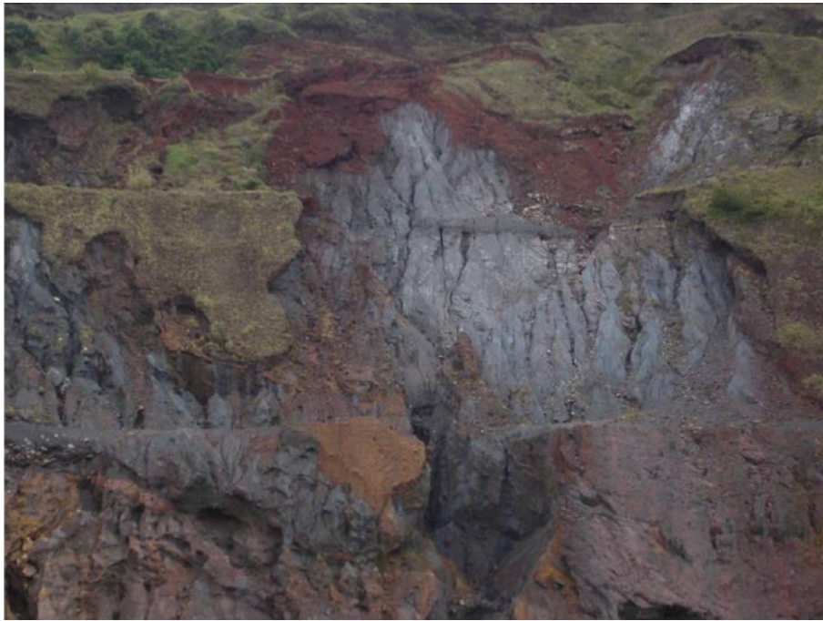
Figura 17 – Erosão em talude de cava para extração de minério. Fonte: GALAS, 2006.
