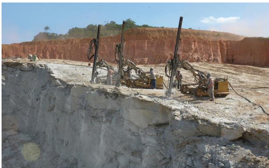
Figura 6 – Brocas realizando perfuração na rocha matriz no processo de mineração de brita. CRAFT Engenharia, 2013.
