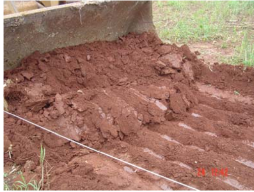
Foto 2 – Raspagem do solo (simulação erosão)
