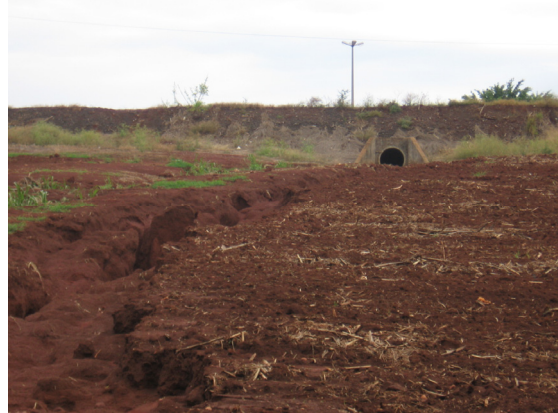
Figura 3 - Erosão na área de cultivo da cana-de-açúcar e sua origem (dreno da Rodovia SP-151)
