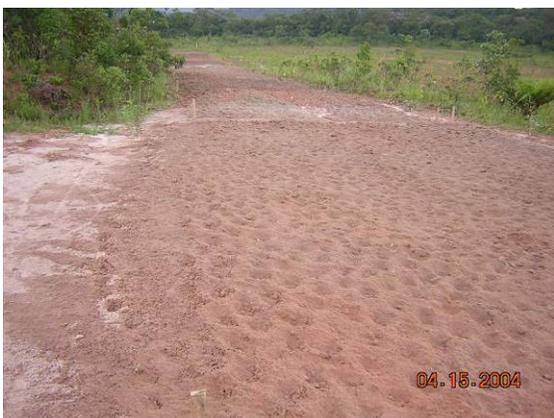
Figura 2.3 - Escarificação feita em toda a área do experimento antes da aplicação da hidrossemeadura
