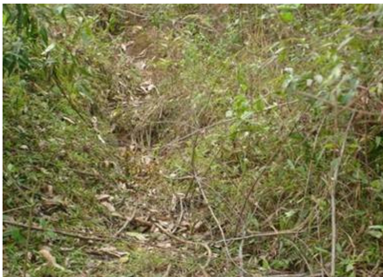
Figura 32 – Processo de erosão aparentemente estabilizado
