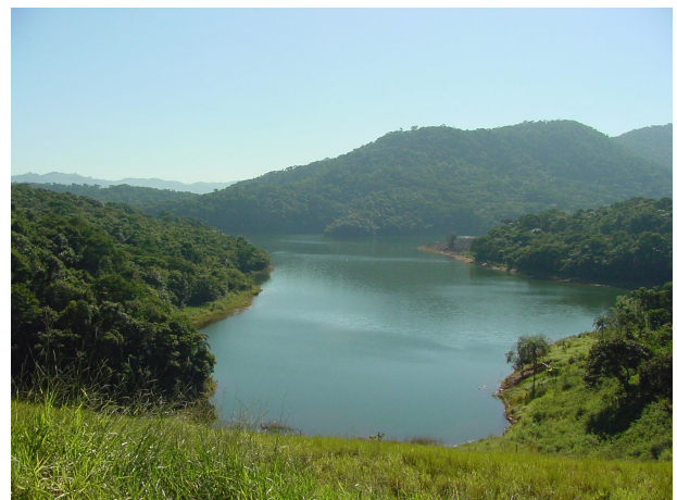
Figura 13 – Vista Parcial do Reservatório do Atibainha
