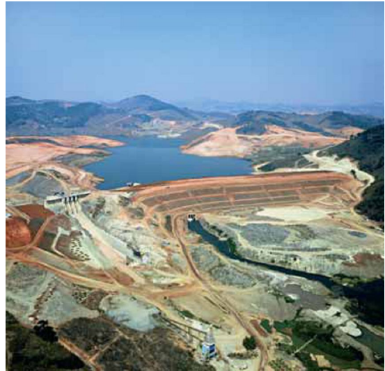
Figura 5 – Construção do Reservatório do Rio Jaguary
