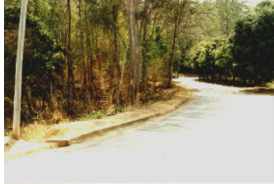
Entrada do bairro. Lateral esquerda mata existente, lateral direita arborização com mangueiras.
