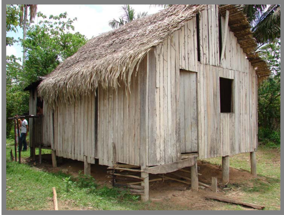
Figura 3. Casa de madeira com telhado de palha na zona rural do município de Manoel Urbano-AC.
