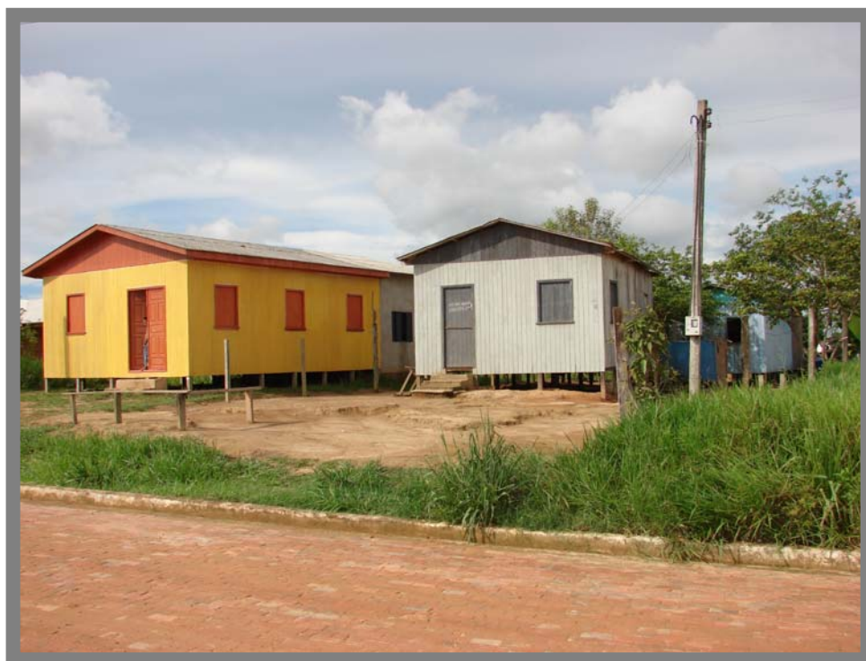
Figura 2. Casas de madeira com telhado de amianto na zona urbana do município de Manoel Urbano-AC.
