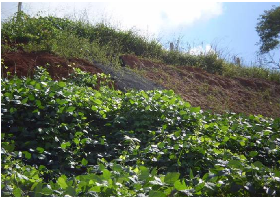
Figura 4C - Talude após um ano e quatro meses de realizada a semeadura, mês de abril de 2008.
