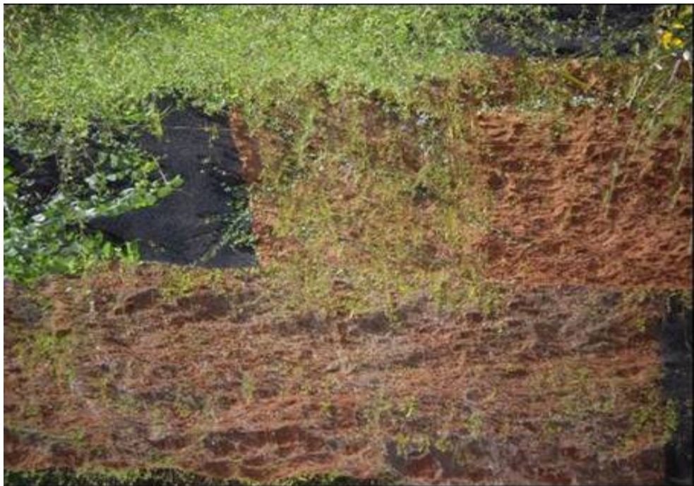
Figura 3C - Talude após um ano e quatro meses de realizada a semeadura, mês de abril de 2008.
