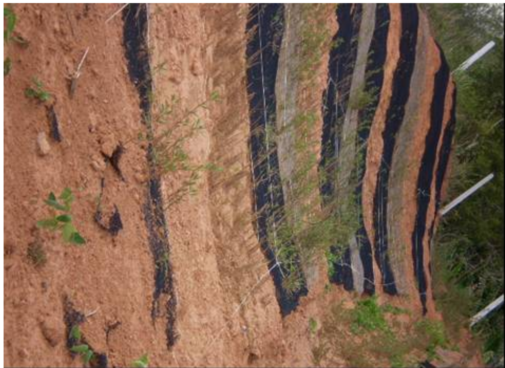
Figura 2C - Talude após um ano e quatro meses de realizada a semeadura, mês de abril de 2008.
