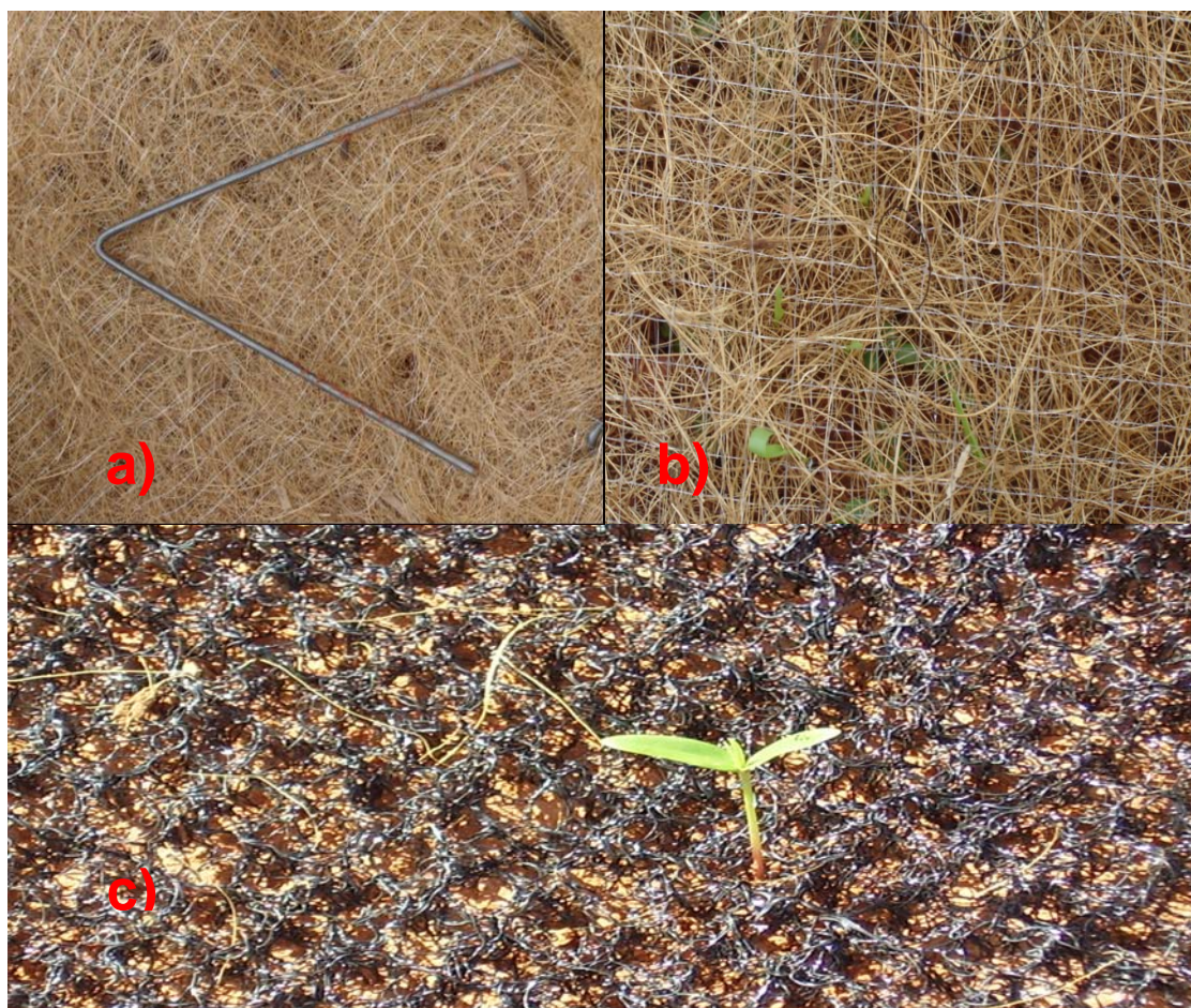
Figura 3 - Materiais utilizados para revegetação de parte do talude com área experimental de 48 m 2 , em Viçosa, Minas Gerais: a) grampos metálicos para fixação das mantas; b) manta FIBRAX ® 400BF, formada por fibras de coco entrelaçadas por uma rede de polipropileno; c) manta MacMat ® , formada por filamentos espessos de determinados polímeros (com emergência de Crotalaria juncea L em março de 2007).
