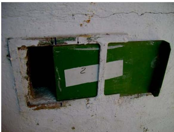
Figura 14: Entrada de ar secundário no combustor, tipo comporta.
