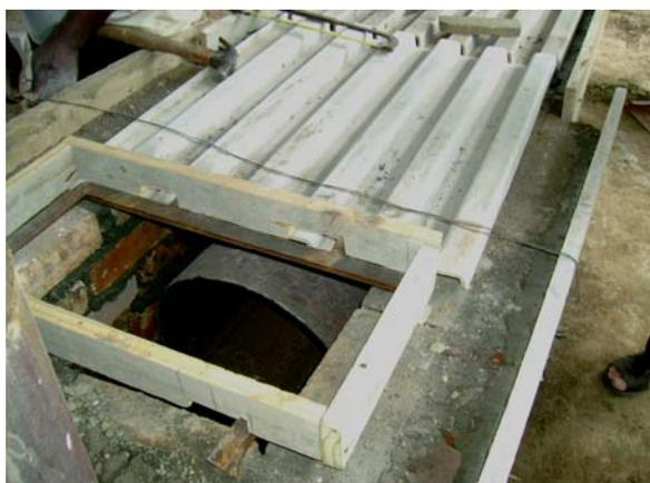
Figura 15: Construção da laje do combustor.
