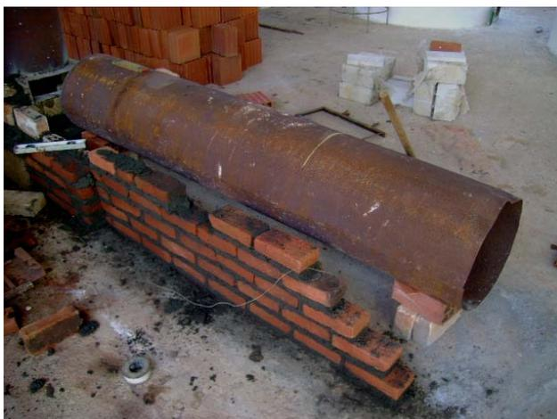
Figura 12: Vista do tubo no interior do combustor.
