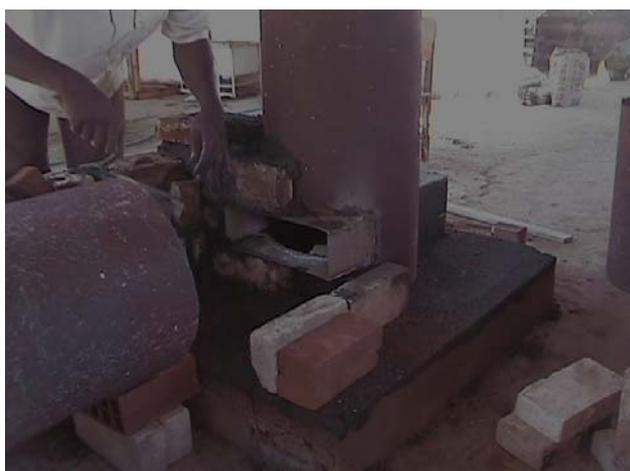
Figura 8: Abertura para saída dos gases do reator.
