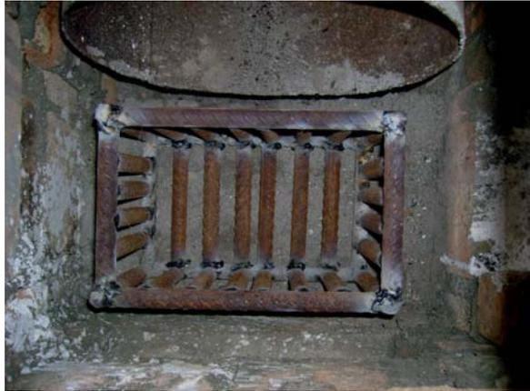
Figura 10: Vista superior da célula de queima dos gases.
