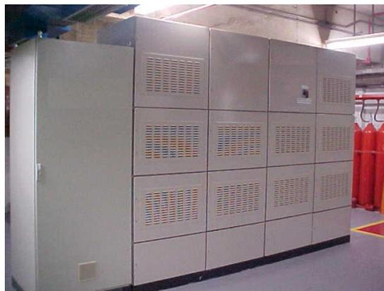
Figura 3.22: unidades de potência (retificadores) e de controle da proteção anódica, instaladas no CCM do digestor (CENIBRA, 2006)
