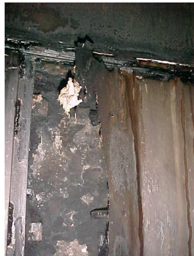
Figura 5.4: corrosão de chapa cega (CENIBRA, 2002).
