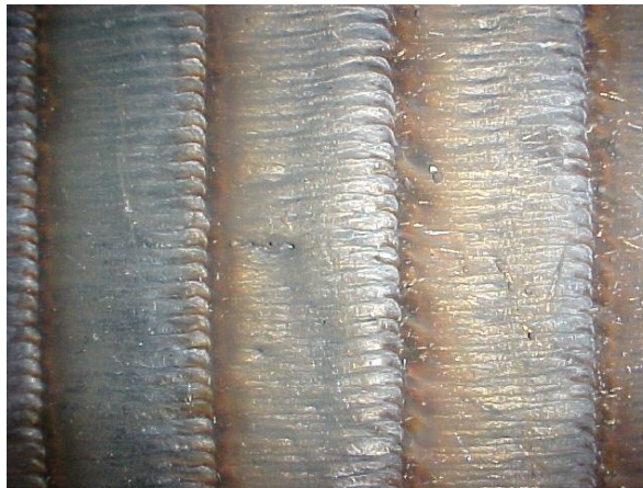
Figura 38: Detalhe da parede reparada.
