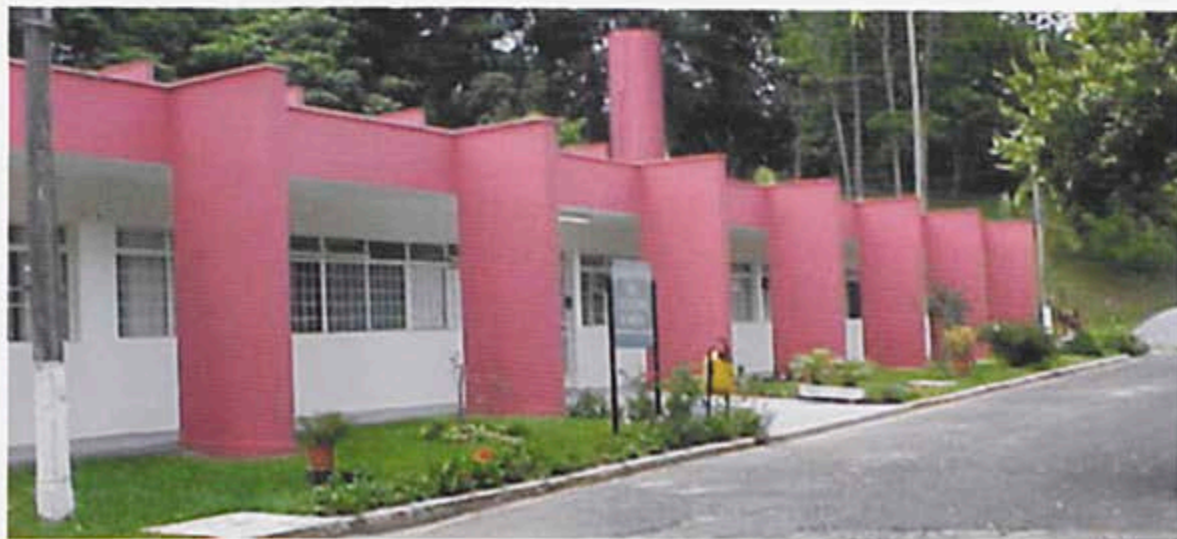
▲ Edifício-Sede do Laboratório de Celulose e Papel.
