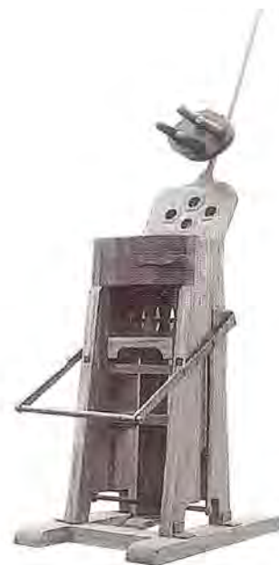
Máquina para fabricar vasos de terra, denominados “Torrão Paulista”, usados na produção de mudas de eucalipto
