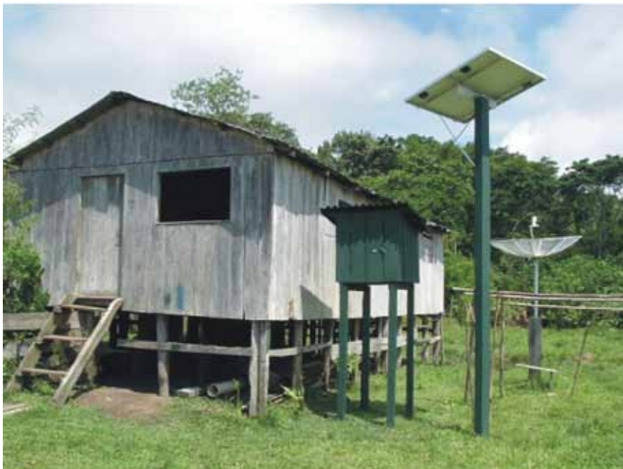
Figura 5. Aplicação de sistema fotovoltaico isolado da rede elétrica, que proporciona energia para a população rural
