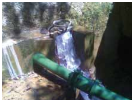
Comporta de fundo da barragem e conduto forçado
