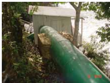
Conduto forçado e casa de máquinas
