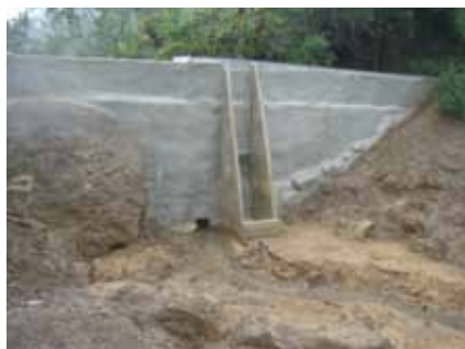
Reservatório sendo desassoreado e construção da grade
