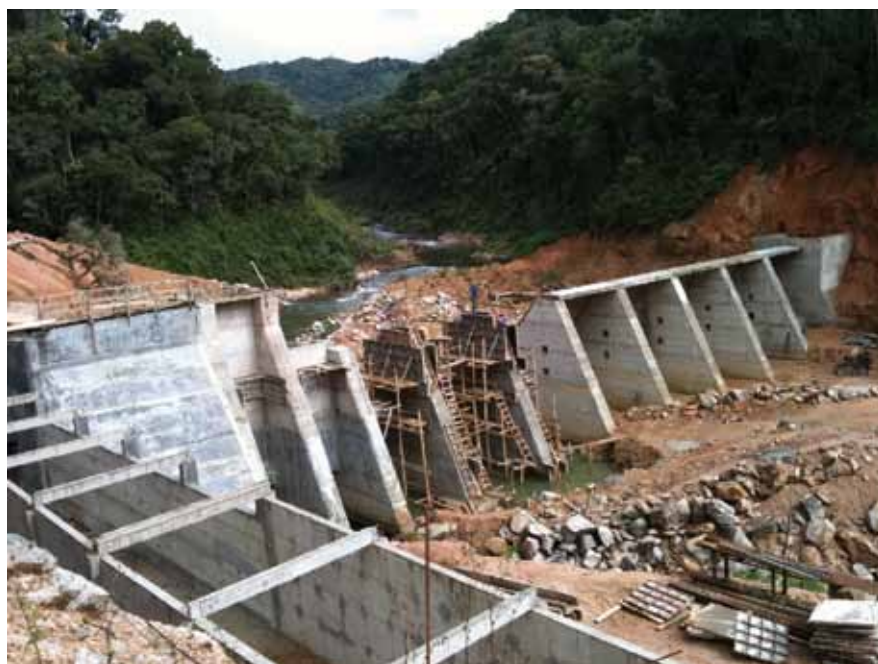
Figura 3 – Vista das obras da barragem e da tomada d'água da PCH Coqueiral
