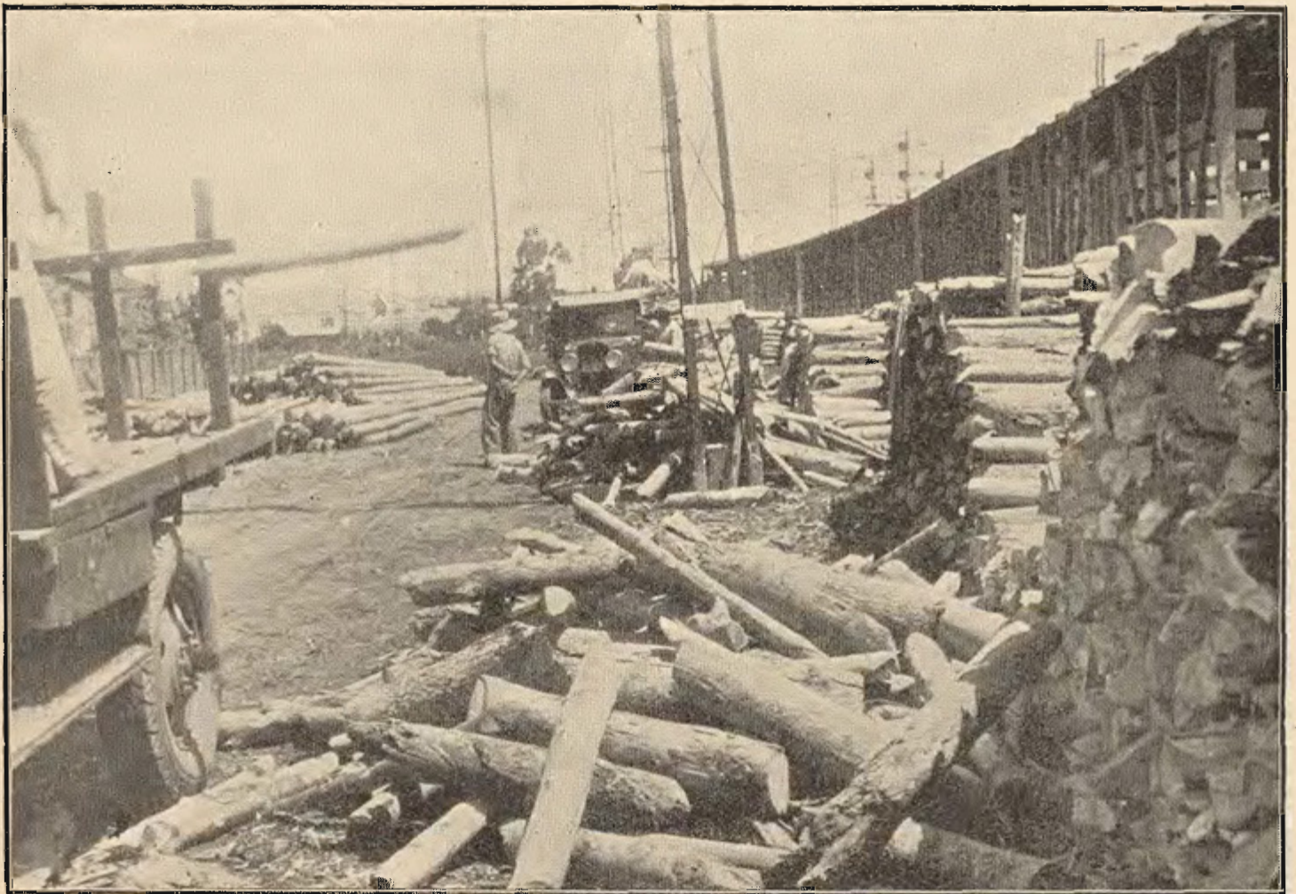
Fig. 81 — Carregamento de lenha e postes no horto florestal de Rio Claro.
