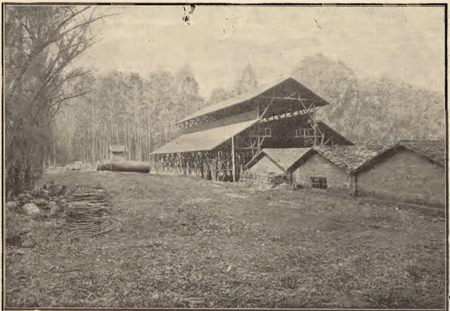
Fig. 68 — Vista lateral da mesma usina da figura anterior.
