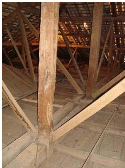
FIGURA 28 Aspecto do pilar D, ao fundo, e do pilar C, à frente, em se pode perceber a regularidade do comprimento do pilar D, comparado ao pilar C.
