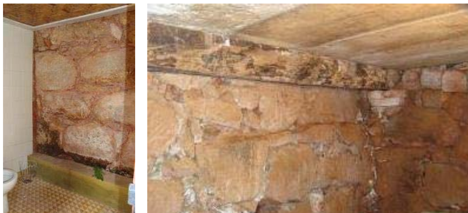
FIGURA 6 Arrimos de moledo em porões, em que A representa o Sobrado dos Quatro Cantos e B, o Casarão dos Moura, ambos em Tiradentes, MG.
