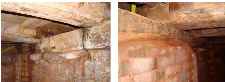
FIGURA 38 Aspecto da viga I, sendo A: apoiando as vigas C e D; B: apoiada em um complemento em tijolos do muro de moledo.
