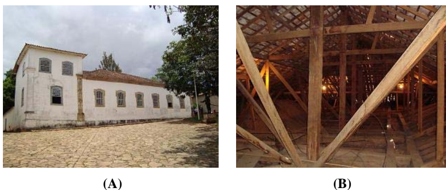
FIGURA 14 Museu Padre Toledo, sendo A: fachada frontal; B: estrutura do telhado.
