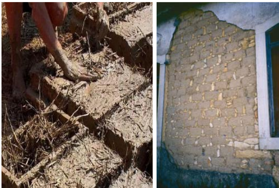
FIGURA 5 A: Adobes sendo moldados; B: Aspecto final de uma parede de adobes.
