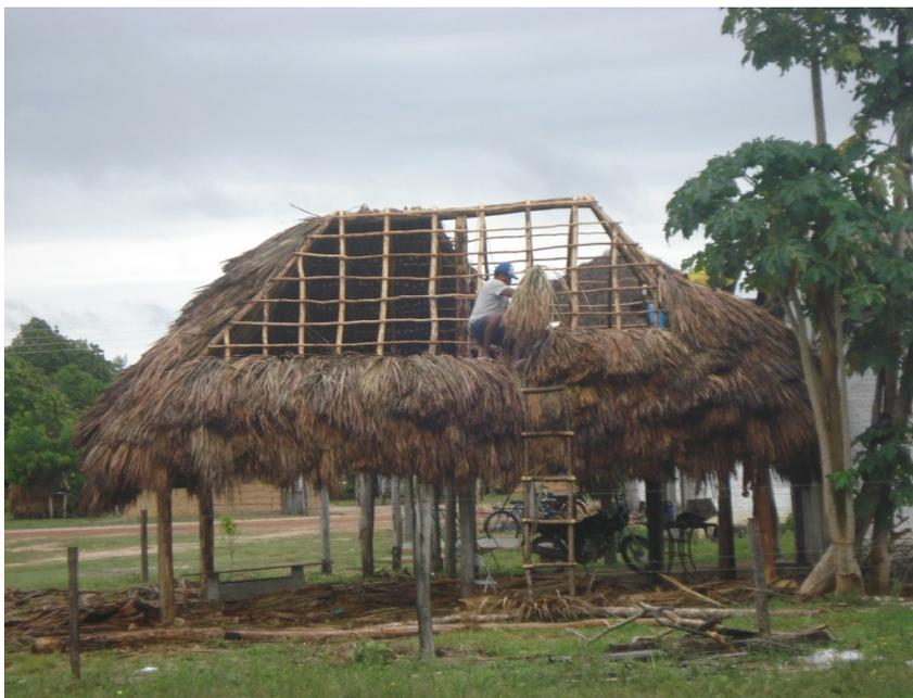
Figura 7: Construção de telhado com palhas de buriti. Foto: Aleksander Hada.
