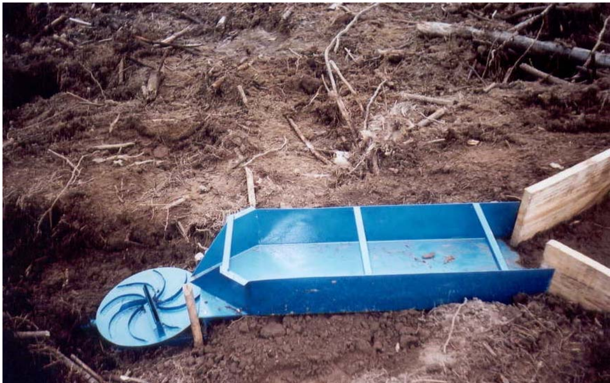
FIGURA 7 - DETALHES DA CALHA COLETORA DE SOLO, NO MOMENTO DA IMPLANTAÇÃO DO PROJETO
