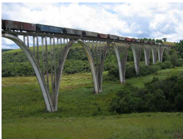
FIGURA 8 - "Ponte dos Arcos" sobre o rio dos Papagaios (sob últimos arcos), Balsa Nova, PR
