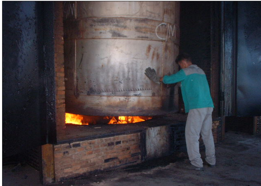
FIGURA 19: ENTRADA DO CILINDRO NO FORNO DE CARBONIZAÇÃO
