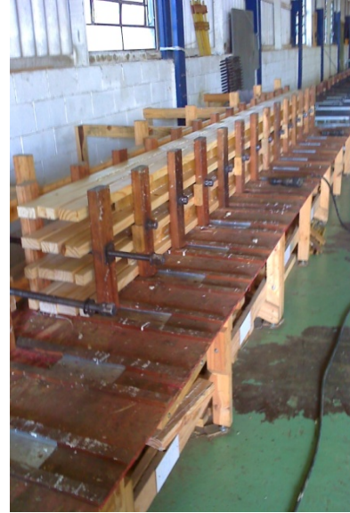
Ilustração 15 - Prensa com quatro vigas sendo executadas simultaneamente
