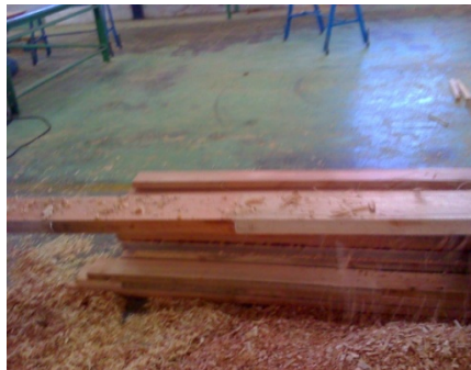
Ilustração 17 - acabamento com remoção de rebarbas através de serragem e lixamento
