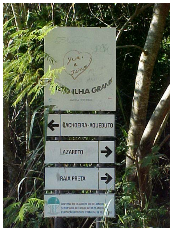
Figura 48: Vandalismo contra placas de sinalização na Ilha Grande. Fonte: CODIG, 2002.
