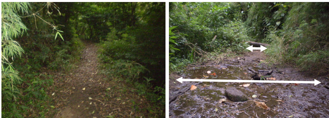
Figura 8.2: Trechos da trilha da Pedra do Sino com boa drenagem (esquerda) e com problemas de drenagem (direita), PARNASO-RJ.
