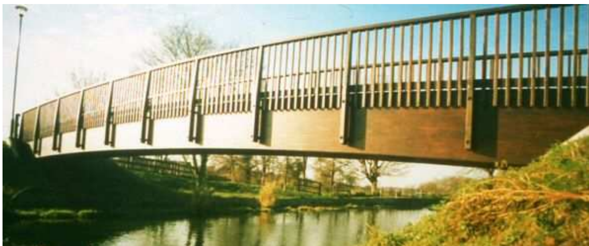
FIGURA 4 - PONTE COM 19 m DE VÃO LIVRE EM MADEIRA LAMINADA COLADA. SLEAFORD, LINCOLNSHIRE
