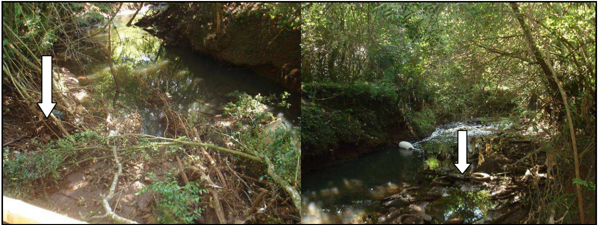
Figura 12. Processo erosivo das margens e formações de pequenas bacias.
