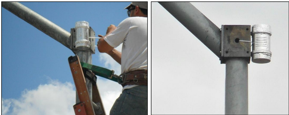
FIGURA 17 - FIXAÇÃO DOS MINI-ABRIGOS METEOROLÓGICOS INSTALADOS NOS SINALEIROS E PLACAS DE SINALIZAÇÃO
