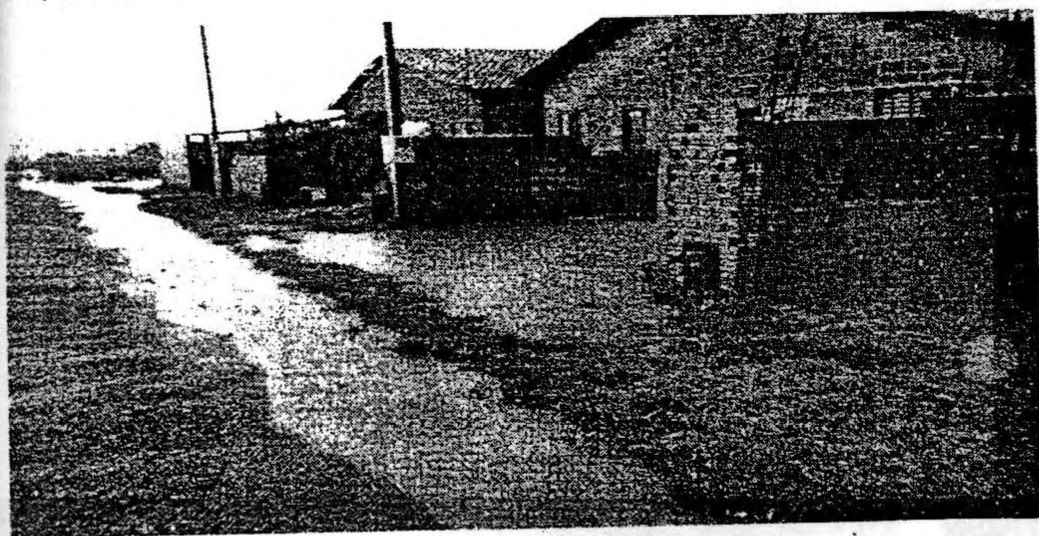
Os alagamentos são frequentes e as casas, abaixo do nível da rua, enchem de água. O prejuízo é crônico.
