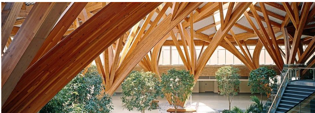
Figura 1 – Credit Valley Hospital, Ontario – Canadá. Projeto: Farrow Partnership Architects Fonte: http://estruturasdemadeira.blogspot.com
