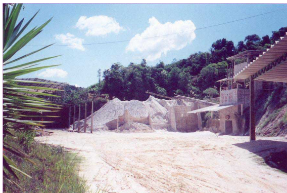
Fig. 10. Forno de cal e depósito de calcário.
