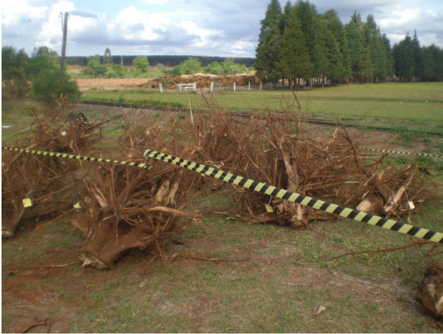
Figura 13 - Separação e marcação dos tocos extraídos pela escavadora após retirada das parcelas
