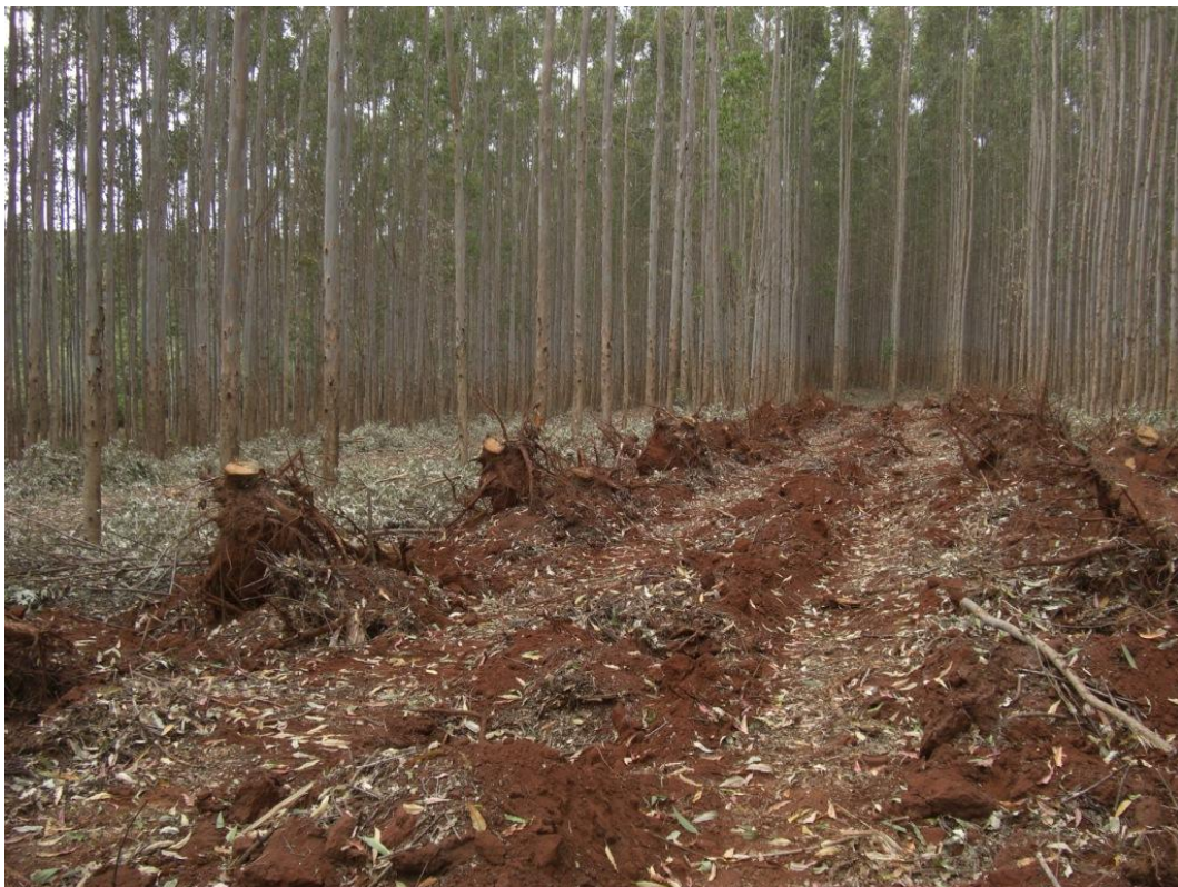
Figura 21 - Superfície do solo após a extração dos tocos com a escavadora
