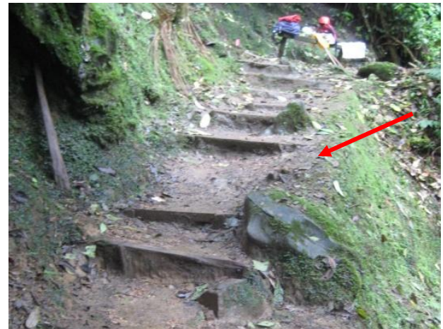
Figura 47 – Situação com a borda crítica obstruída e rastro do caminho da água
