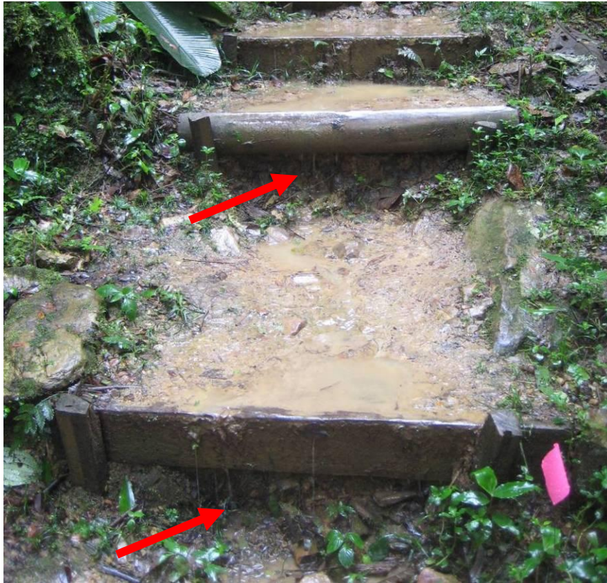
Figura 34 – Erosão em base de degrau no Núcleo Ouro Grosso
