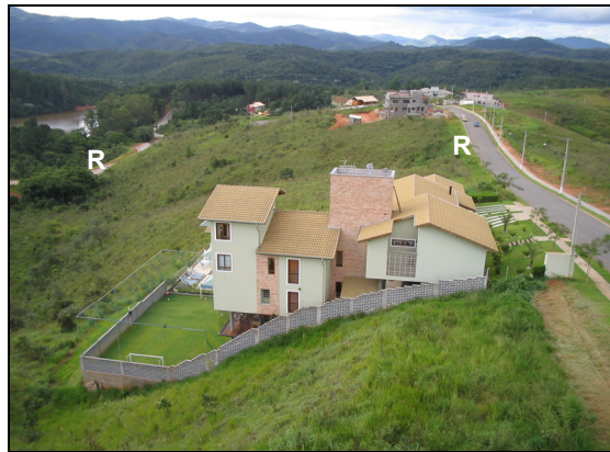
Figura 15 – Ambiente de campo antrópico destacando as casas e construções da “Reserva Ibirapitanga”, e parte das ruas (R) onde foram feitos os registros avifaunísticos
