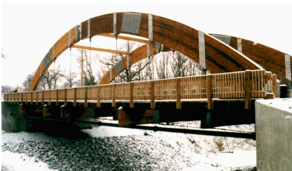
Figura 5 - Viaduto construído com MLC de eixo reto e curvo (Fonte: http://www.maggertengineers.com/ )
