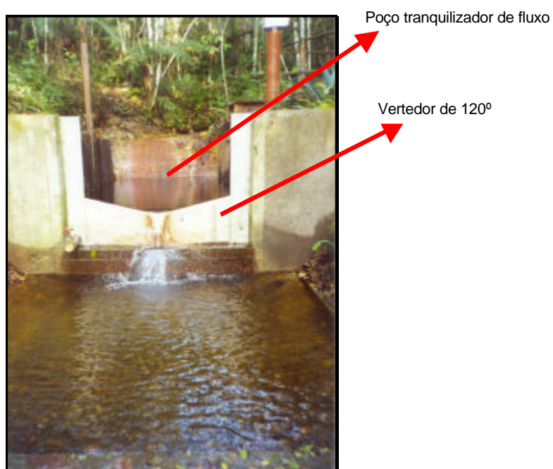
Figura 11 - Visão à montante do vertedor instalado na microbacia E
