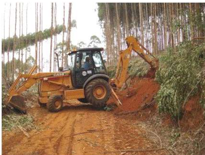
Figura 9 – Operação de construção das rampas para acessibilidade das máquinas analisadas.
