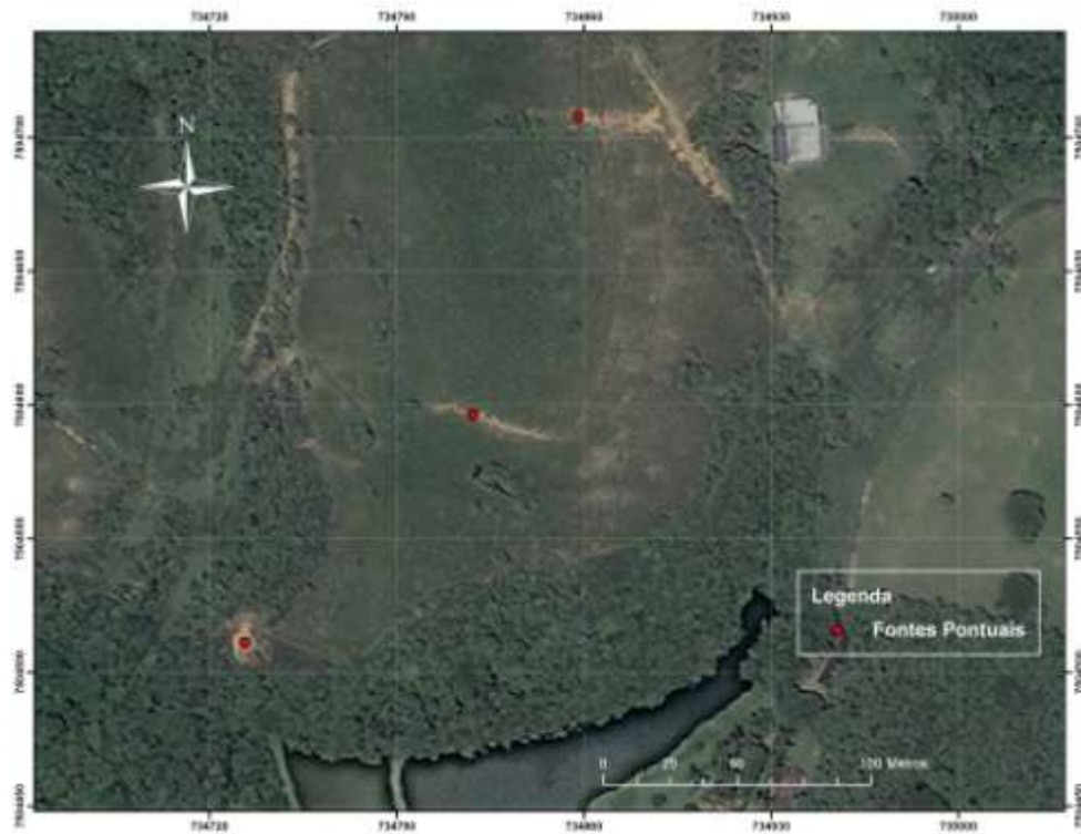
Figura 78: Exemplificação de fontes pontuais de emissão de sedimentos, dentro da bacia hidrográfica do rio Macacu/RJ. Ravinas e voçorocas.
