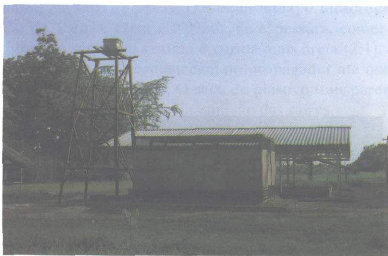
FIG 2 — Aspecto externo de um viveiro de enraizamento.
