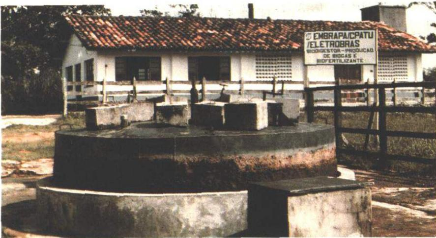
FIG. 69. Utilização de esterco e restos vegetais para a produção de energia e fertilizante em construções especiais denominadas biodigestores é uma forma muito promissora. Vista de um biodigestor modelo indiano. (Gentileza do Dr. Sérgio de Mello Alves).
