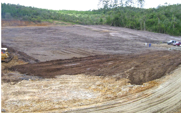
Figura 4. Vista geral da área de pesquisa, no início das atividades de preparação do terreno. Doutor Pedrinho, SC, em 05/01/2004.
