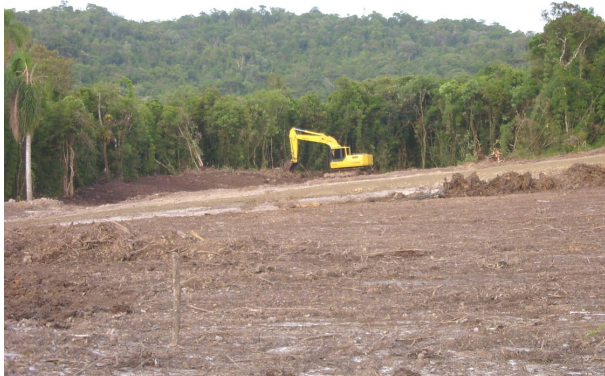
Figura 6. Área adjacente de onde foi retirada a serapilheira e o horizonte A. Doutor Pedrinho, SC, em 06/01/2004.
