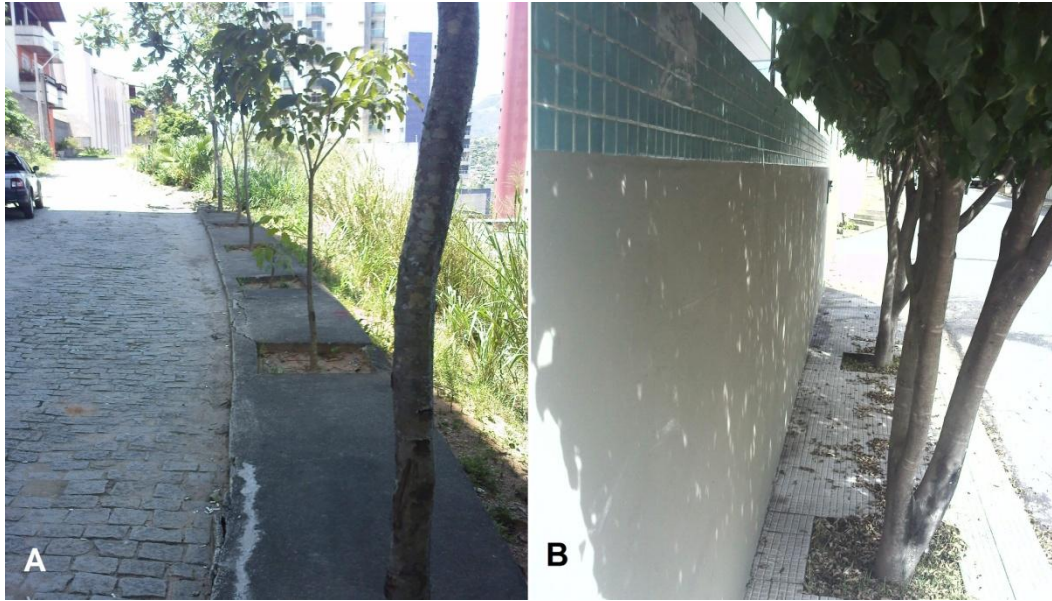
Figura 23 – indivíduos arbóreos dificultando a passagem de pedestres no passeio. A – Tabebuia roseo-alba , B – Ficus benjamina .
