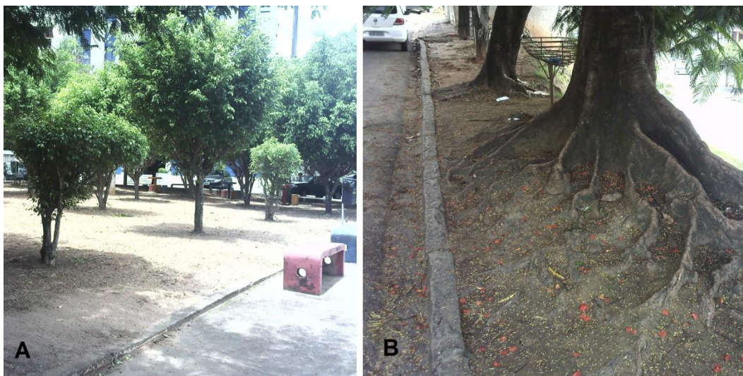
Figura 24 – A – Ficus benjamina plantado em uma praça no bairro Dr. Gilberto Machado, B – Delonix regia próxima a rua em local onde não havia passeio no bairro Recanto.
