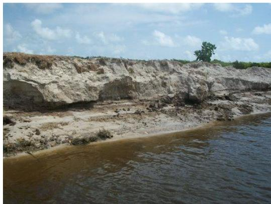
Figura 6- Erosão em parede de viveiro de camarão provocando assoreamento do canal fluvial.
