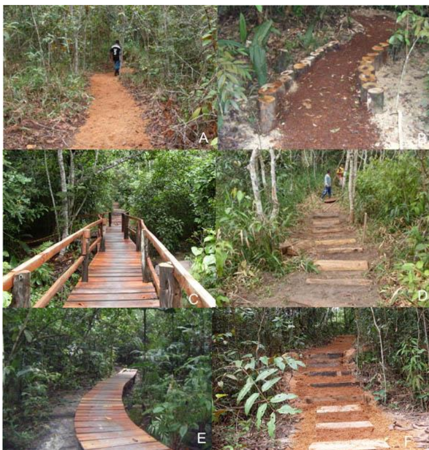
Figura 19. Sistema de trilhas do PAREST Sumaúma: A e B serapilheira de madeira, mantém aspectos naturais; demarca a trilha e evita abertura de caminhos paralelos; C e E pontes de madeira sobre cursos d'água; D e F Estivas de madeira acompanham o relevo em forma de escadas;
