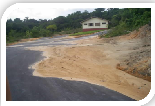
Erosão antes da construção
