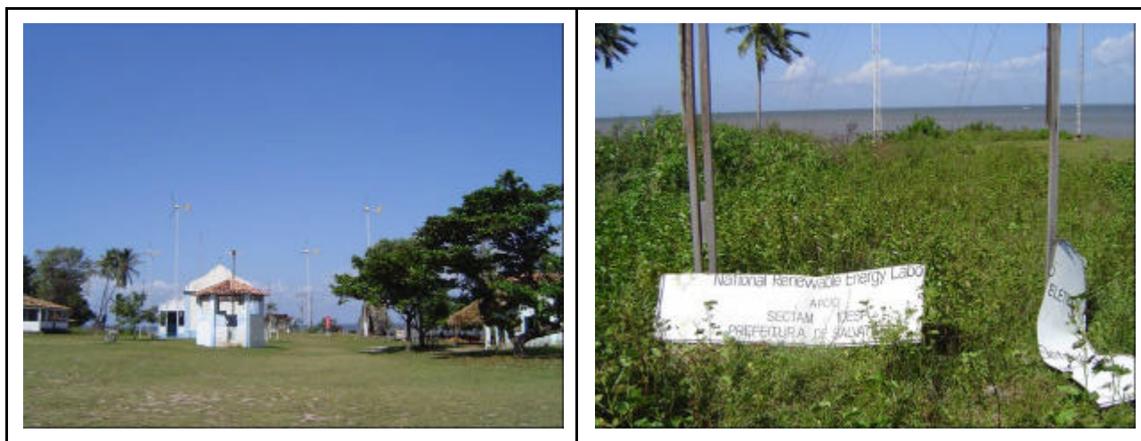
Figura 28 – Praça de Vila Joanes com torres dos aerogeradores desativados ao fundo (esq.) e placa de identificação do projeto danificada (dir.)
