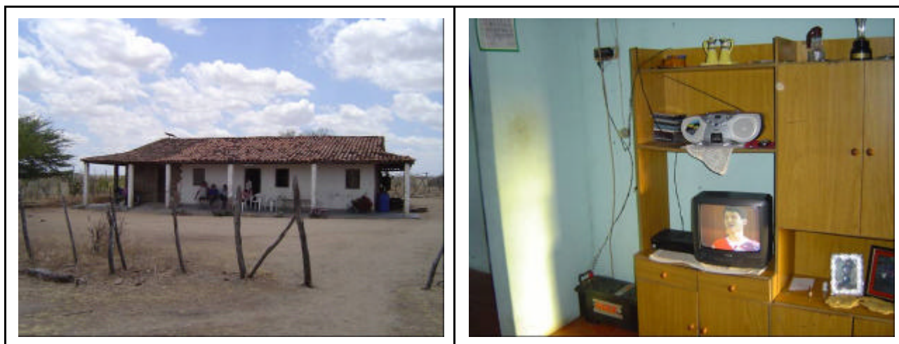
Figura 32 – Casa típica da região com painel fotovoltaicos à esquerda do telhado (esq.) e conjunto controlador de carga (parede) e bateria (dir.)
