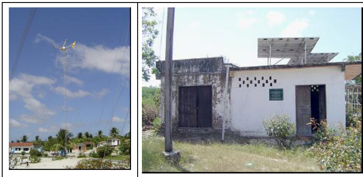
Figura 24 – Um dos aerogeradores, escola e telefone público ao fundo à esquerda (esq.) e painéis fotovoltaicos sobre a casa de força (dir.)
