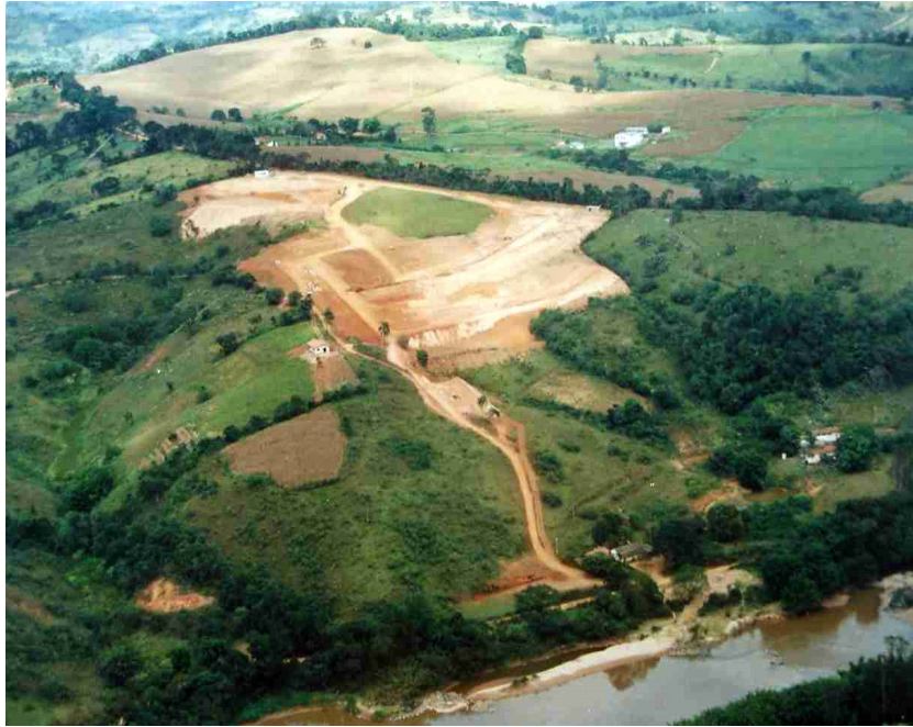
FIGURA I 10 Remoção da cobertura vegetal para criação da infra-estrutura básica da UHE FUNIL.
