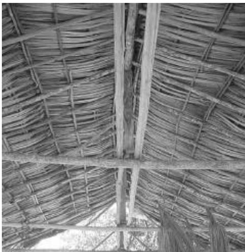
Figura 8. Arquitetura de um telhado de palha de buriti.
